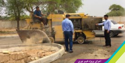
اجرای پروژه فیبر نوری
